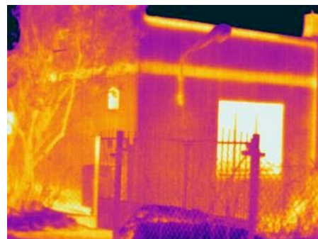
Рис. 2. Кладка стен из газобетона YTONG® на раствор для тонкошовной кладки YTONG®
